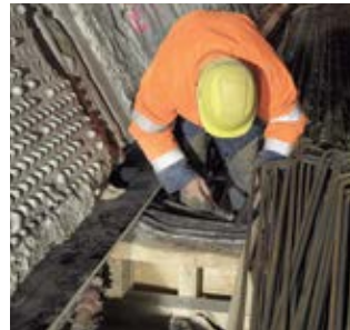
Tunnel- och kanalbyggnation
