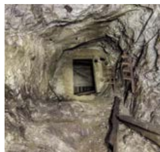
Stålkonstruksjon og gruvedrift
