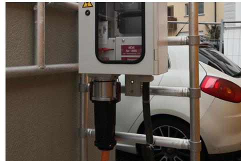
Baustromverteiler
